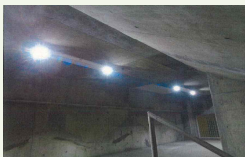
パトリア桶川 バックヤード階段
